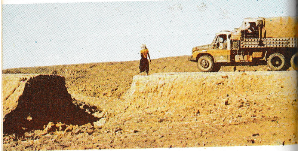
39. Největší pohroma, která se na Sahaře vyskytuje jen vzácně, je déšť. Hliněné domky se rozmočí... a na hlavní silnici v Tassíli se objeví takovéto mezery
